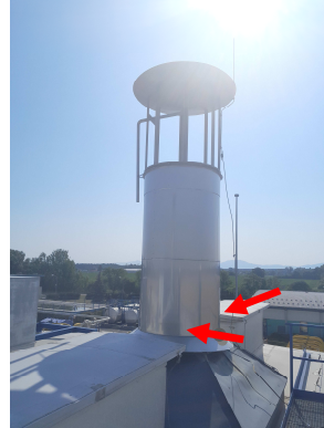
Obrázok č. 2 Pohľad na komín turbokompresora TK2/4, vyznačenie meracích miest
