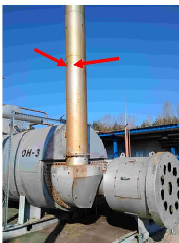
Obrázok č. 5 Pohľad na komín kotla OH 3, vyznačenie meracích miest – ZS7
