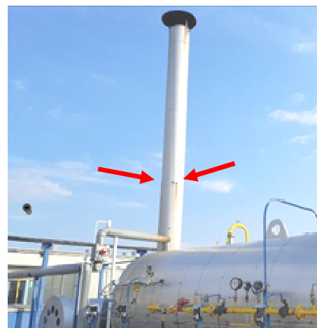
Obrázok č. 3 Pohľad na komín kotla OH 2C, vyznačenie meracích miest – ZS6
