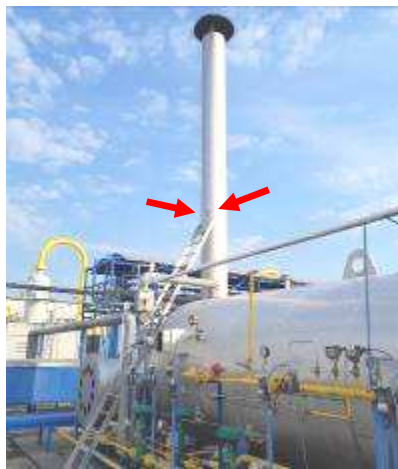
Obrázok č. 2 Pohľad na komín kotla OH 2B, vyznačenie meracích miest – ZS6
