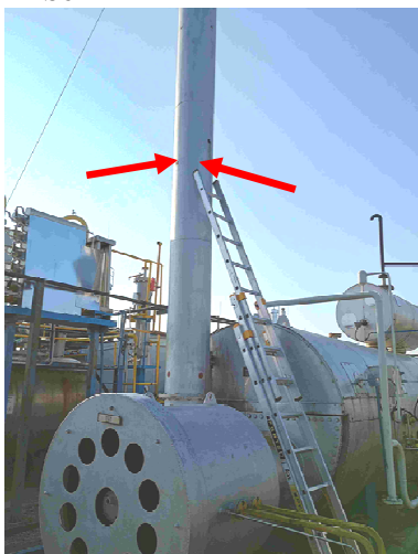
Obrázok č. 4 Pohľad na komín kotla OH 1, vyznačenie meracích miest – ZS6
